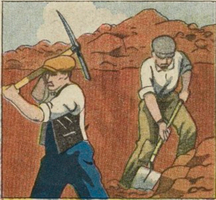
On creuse les fondations.
