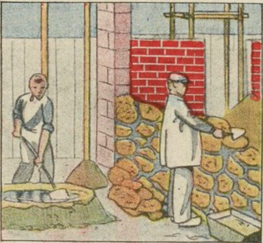
On construit les murs.
